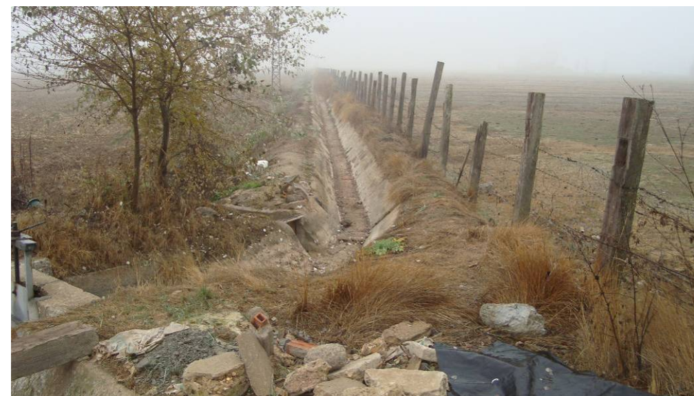
Aspectos de las acequias en la zona de actuación
