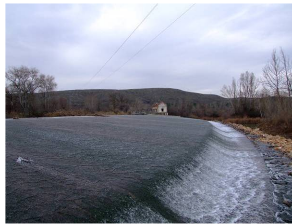
Presa del Embocador después de la adecuación de la presa. Fuente: elaboración propia.
