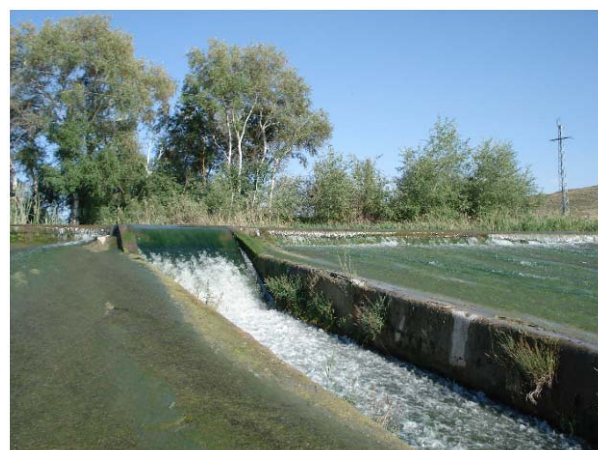
Presa del Embocador antes de la reforma. Fuente: Panoramio.
